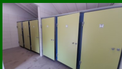
Sanitaires après travaux
